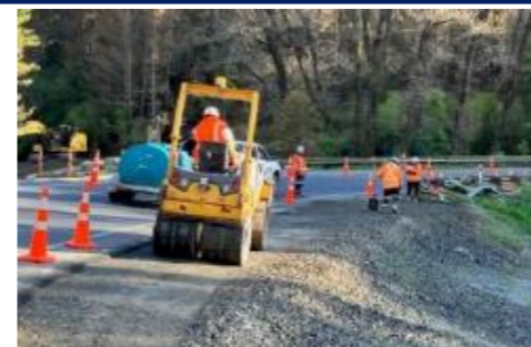
TREC Contractor - Te Ngarue Culvert (TREC Newsletter)
